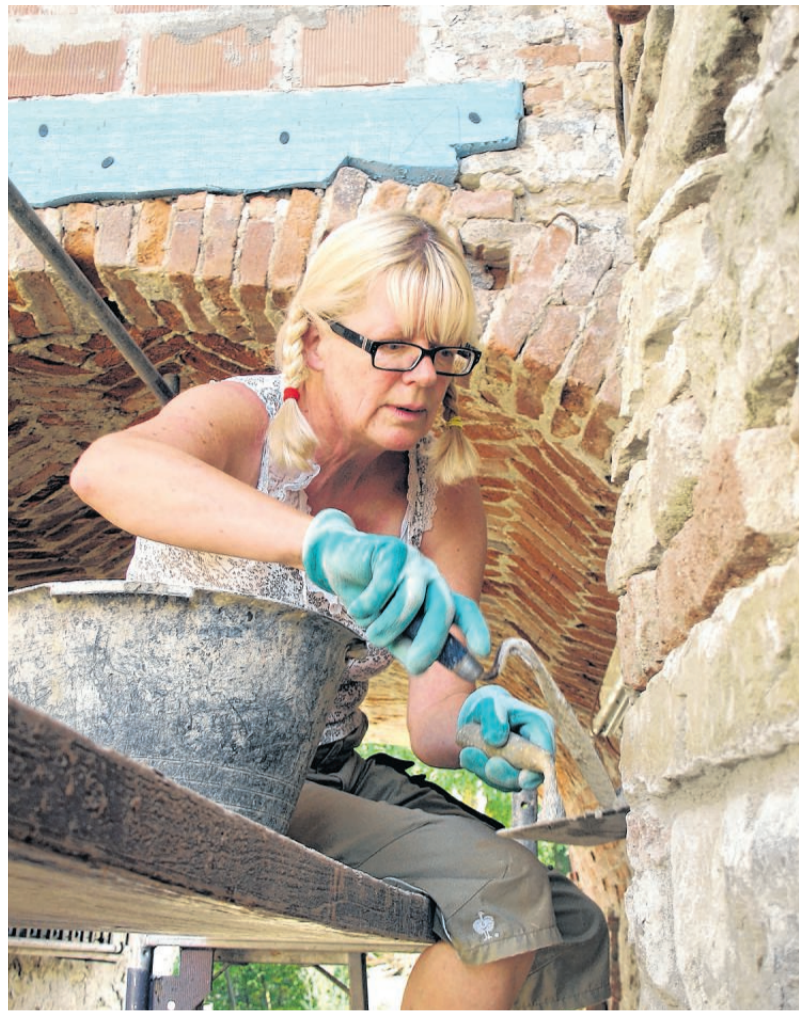
Sie sitzt auf dem Gerüst und schwingt die Kelle, um das Natursteinmauerwerk des zerfallenen Gehöfts auszubessern. Eine Arbeit, die Gabi Schneider befriedigt.
